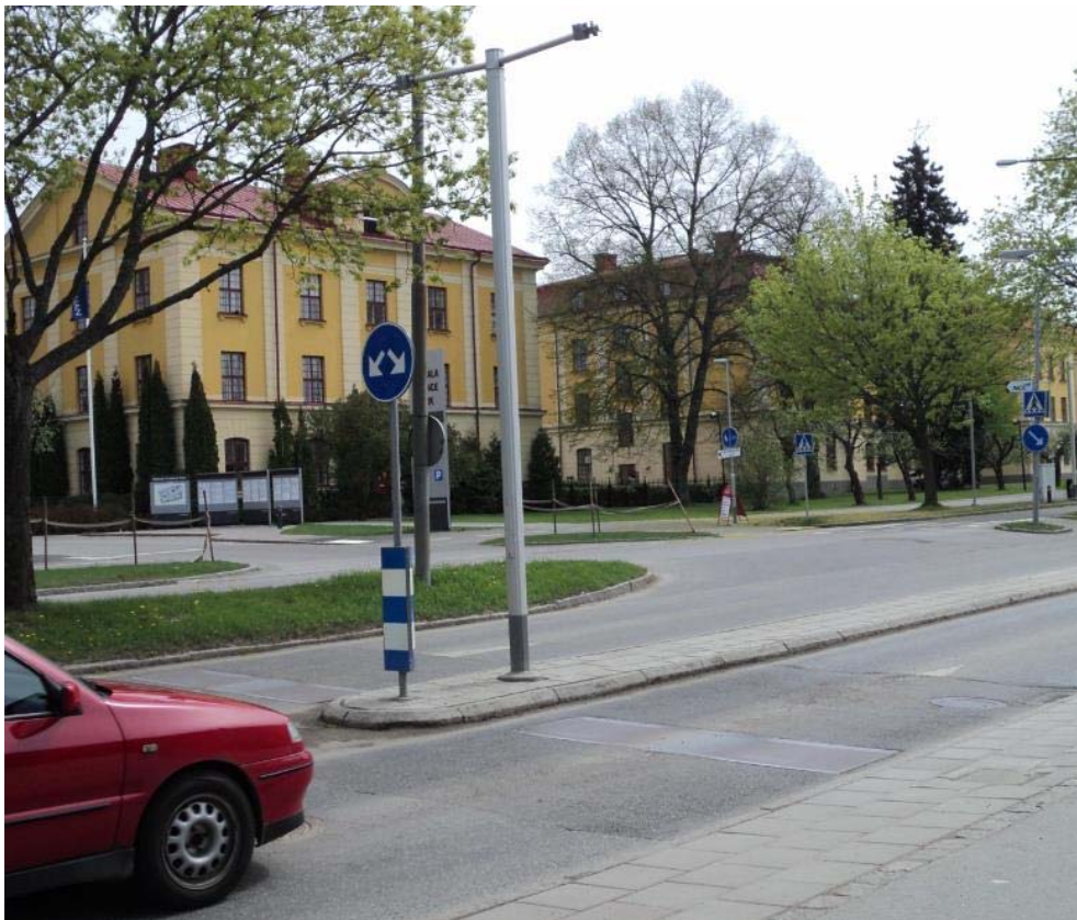
Figur 1-2 Foto på platsen före åtgärd (ovan) samt foto på platsen efter åtgärd: Actibump på västra sidan (nedan). Foto: Leif Franzén.
